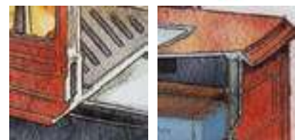
Слева: для увеличения герметичности при закрытой створке дверцы, согласно точному расчету, вторая створка плотно входит в паз с помощью фибerglassового шнура.
